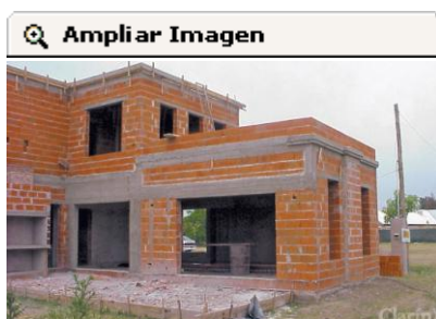
Dinteles. Se deben extender por lo menos un tercio de la luz a ambos lados de las jambas.
