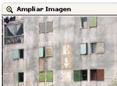
Persiana metálica exterior. El sobrepeso de la hoja puede vencer las bisagras y dificultar su manipulación.
