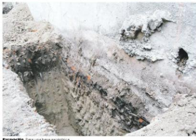
Excavación. Para una base excéntrica
