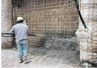
Proyectado. Pantalla de submuración con hormigón
