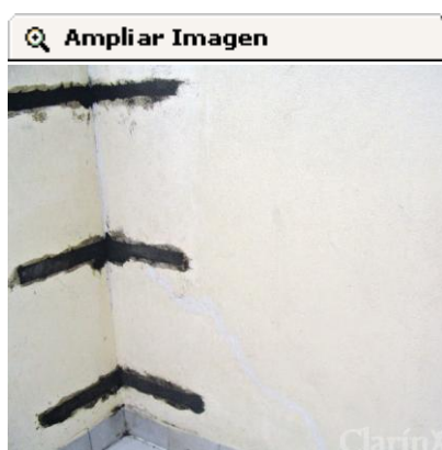
Llaves. Una solución poco efectiva para las fisuras.
