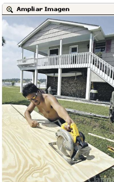
Zona de riesgo. Las fallas de cálculo suelen salvarse a veces con soluciones improvisadas en la obra.
